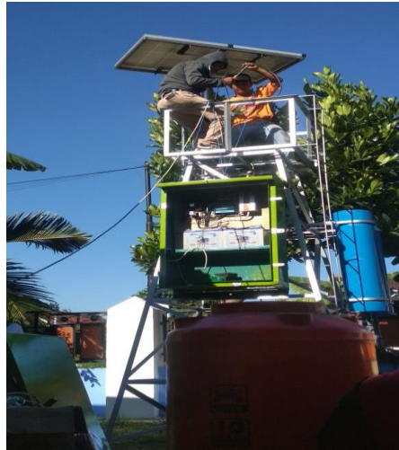
Gambar 9. Perakitan alat pengolahan air bersih
