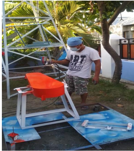
Gambar 7. Pengecatan dasar rangka utama alat pengolahan air bersih
