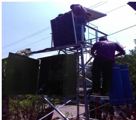
Gambar 8. Pemasangan tabung sadimentasi untuk alat pengolahan air bersih
