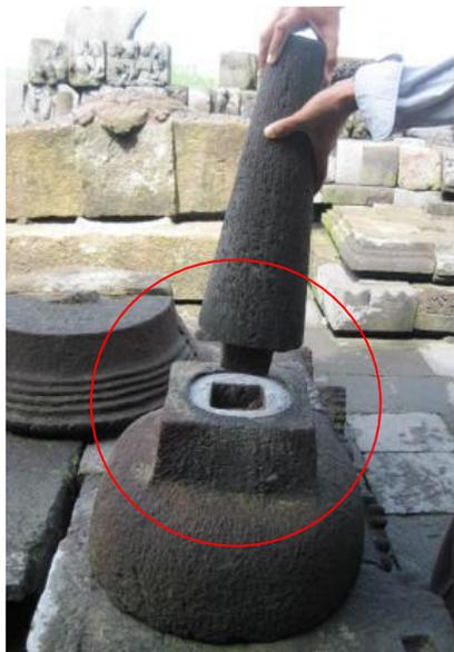
Gambar 1: Inspirasi desain batu bata pada konstruksi candi dengan model purus lobang yang tidak
