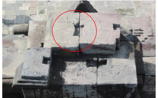
Gambar 2: Inspirasi desain batu bata pada konstruksi candi model dengan model ekor burung yang memungkinkan untuk pasangan batu bata.
