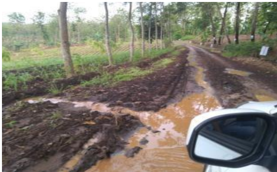
Gambar 1 (a) Akses Jalan Menuju Desa Mentasan Dari Arah Timur
