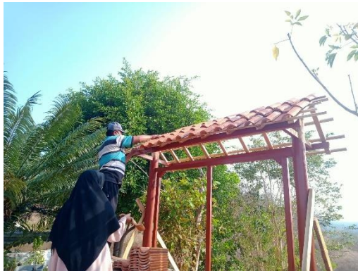
Gambar 1.7 Pemasangan Papan Informasi
