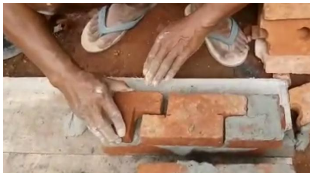
Gambar 4. Pemasangan Batu Bata dengan Desain Baru
