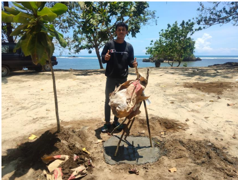
Gambar 3. Pemasangan Beton Pondasi Kincir Angin
