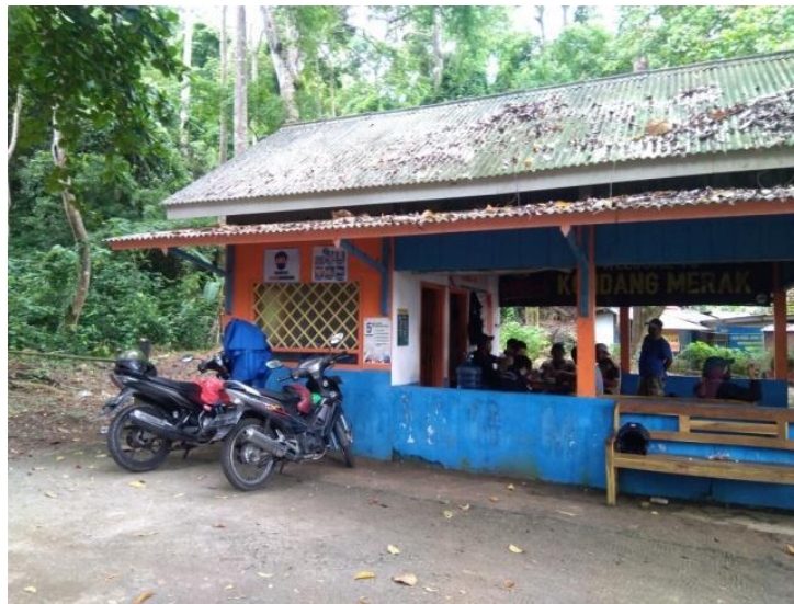
Gambar 2. Lokasi Pemasangan Stasiun Charging
