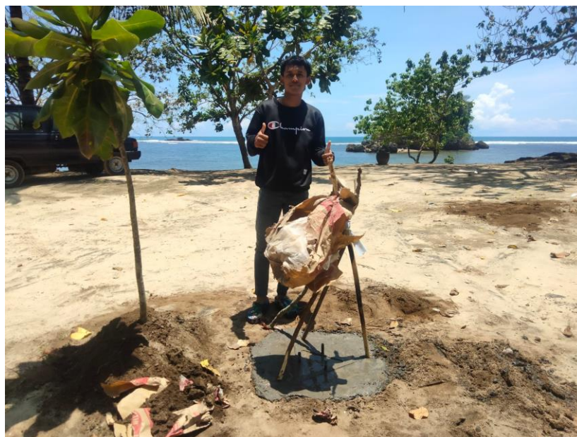
Gambar 3. Pemasangan Beton Pondasi Kincir Angin
