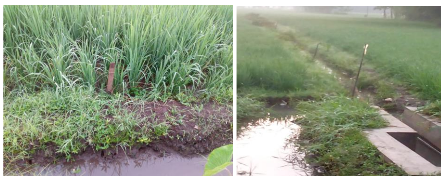
Gambar 3. Pembuatan Parit dan Pemasangan Tonggak di Parit
