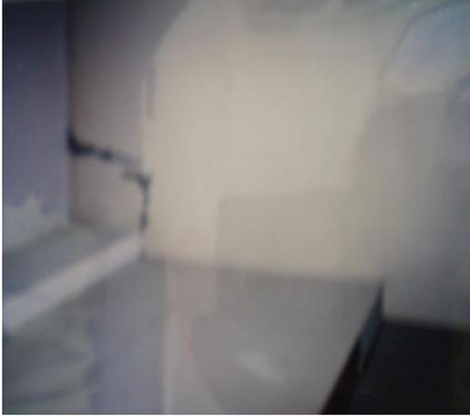
**Gambar 1:** Gambar contoh kerusakan pada balok beton.
